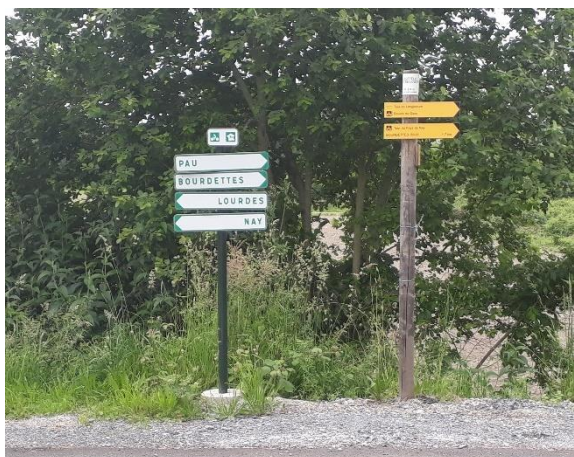
Figure 15 – Jalonnement de la véloroute à Baudreix et Tarsacq Manque des notions de distance et/ou de temps de parcours
