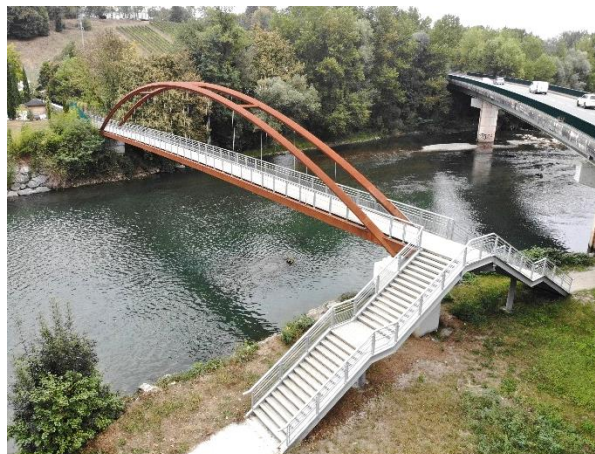
Figure 11 – Passerelle entre Mazères-Lezons et Bizanos
