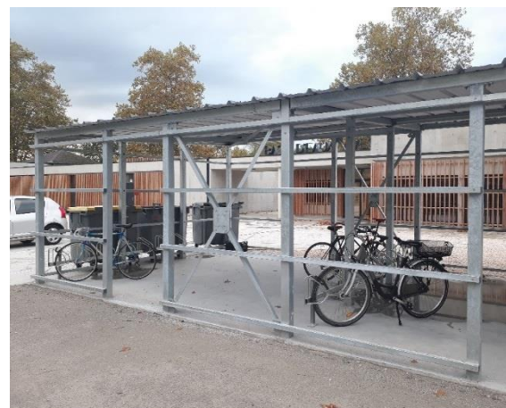
Figure 23 – Base d'Eaux Vives : Absence de jalonnement et arceaux de stationnement inadaptés
